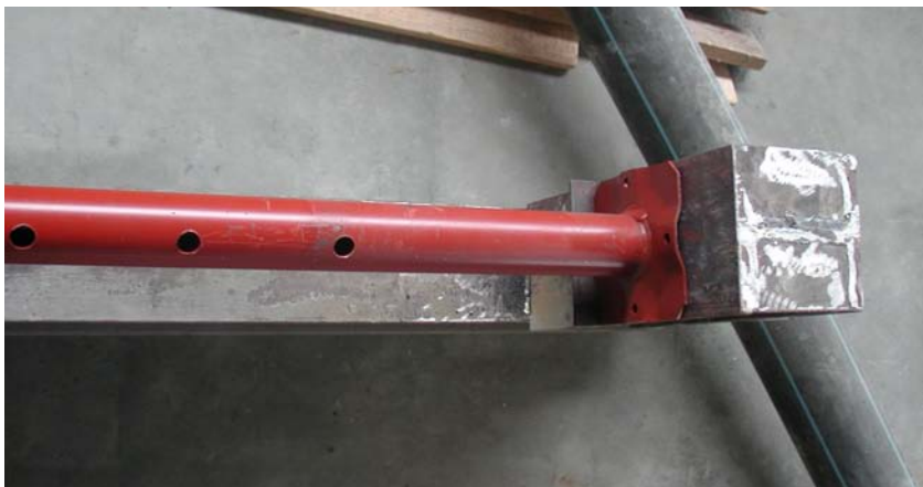
Foto 8, posicionamiento del apoyo superior.
