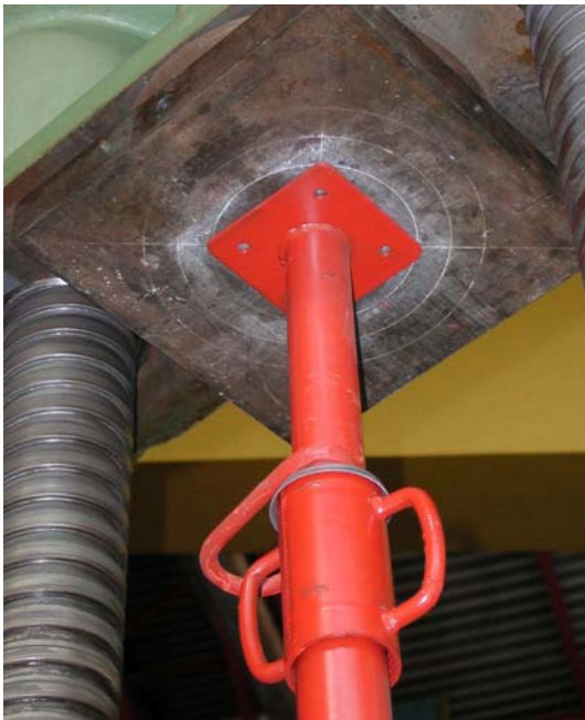
Foto 6, posicionamiento del apoyo superior.
